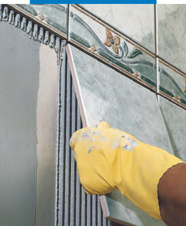
Egyszer égetett burkolólap ragasztása vakolatra
