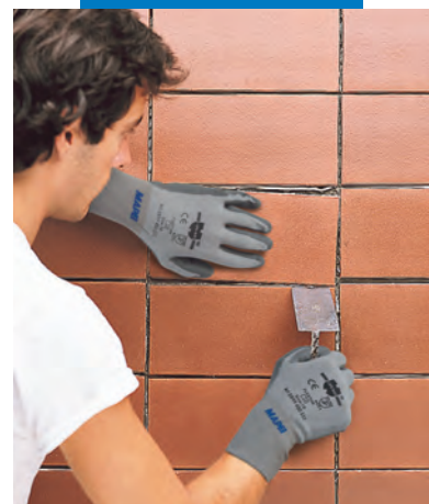
Burkolólapok ragasztása meglévő burkolólapokra szürke Adesilex P9-cel
