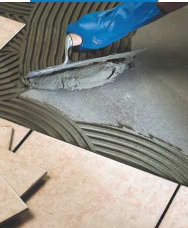
Egyszer égetett burkolólap ragasztása padlóra
