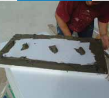
Mapetherm Ragasztótapasz alkalmazása ragasztóként kisméretű táblára
