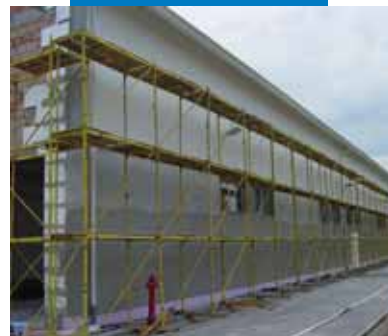
A hőszigetelő panelek felragasztása után 24 órával Mapetherm Ragasztótápasz alkalmazása simítóanyagaként
