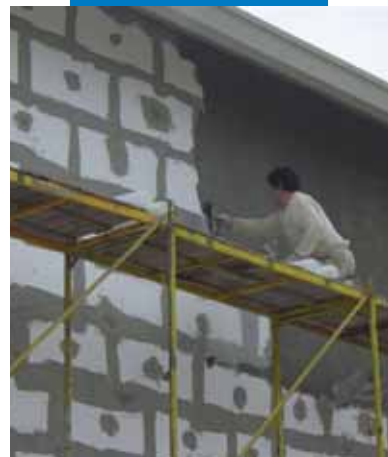
A hőszigetelő panelek felragasztása után 24 órával Mapetherm Ragasztótápasz alkalmazása simítóanyagaként
