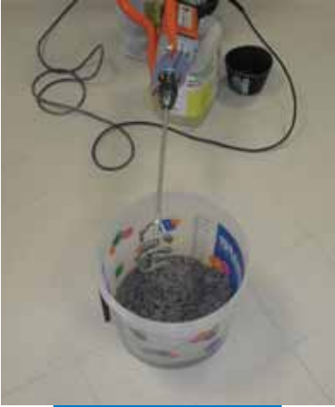
Mapetherm Ragasztótapasz keverék készítése
