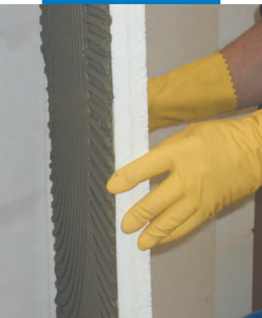
Hőszigetelő panel felhelyezése
