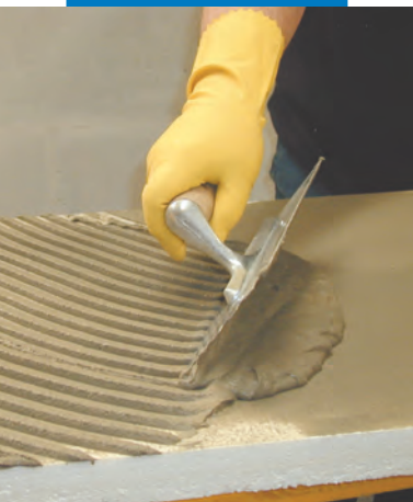
Mapetherm AR1 felhordása a tábla hátoldalára fogazott simítóval
