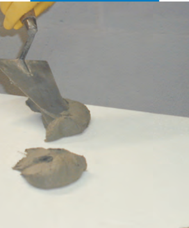
Mapetherm AR1 felhordása a tábla hátoldalára pontokban vakolókanállal
