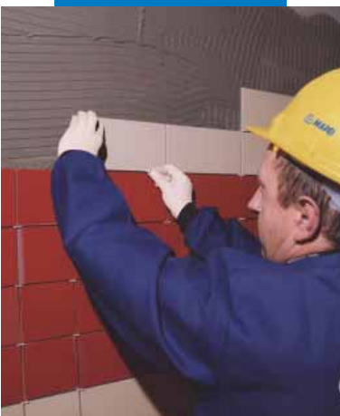
Kerámia burkolólap ragasztása falra
