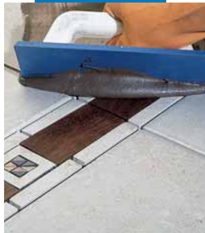
Faberakásos kerámia padlóburkolat fugázása simítóval
