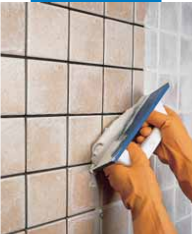
Egyszer-égetett falburkolat fugázása simítóval
